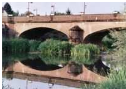
Pont de la Bourbeuse
