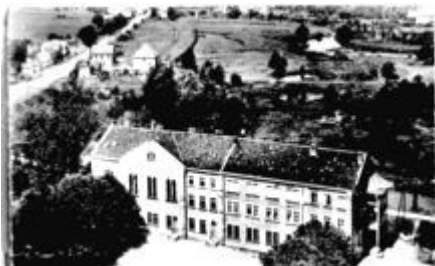
Vue aérienne du Séminaire de Bourogne
